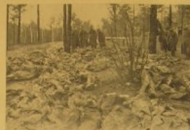
Blick auf die Seite der Dämme. — In der Mitte polnische Hilfsgräber, die an dem Baugrubenreihen beiseite sind. Widok na stronę rzep. — W środku polskie groby pomocnicze przy wydobywaniu żelaz.
